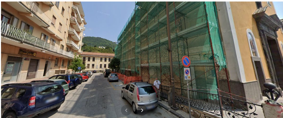
Figura 9 - stato di fatto
